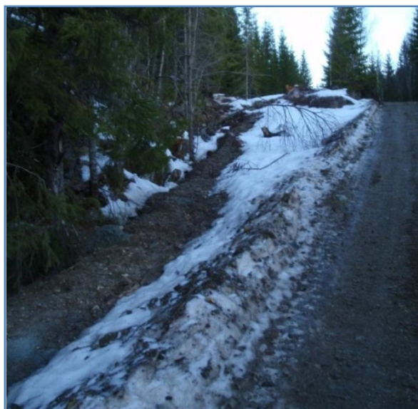
Figur 11 Rørtrasè og vei opp mot Ausvatnet
