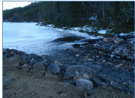
Figur 8. Utløpet fra Ausvatnet ned i elva.
