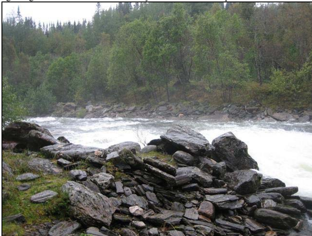
Foto 9. Det er utført elveforebygging i nedre del av Styrkesneselva. Arbeidet ble utført på 60 tallet for å hindre erosjon langs elvebredden. Elveforebyggingen medførte negative biologiske effekter, da gyteområder ble ødelagte.
