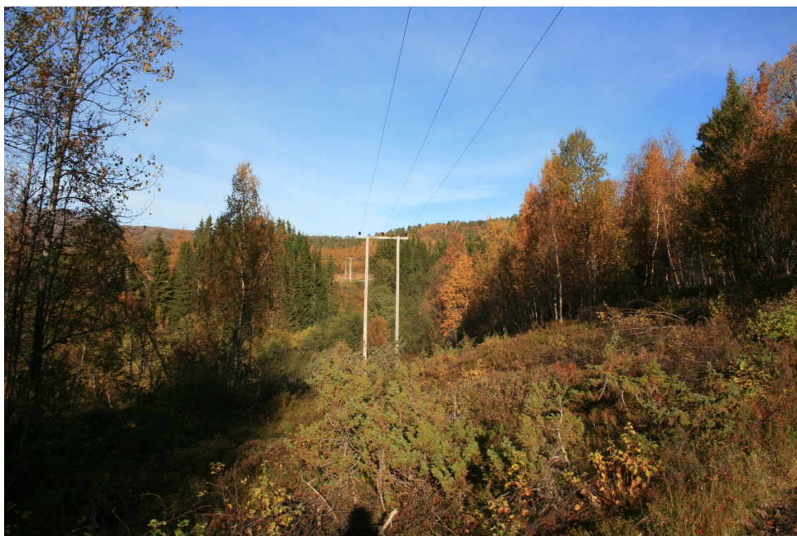
Figur 2.9 Den eksisterende kraftlinjen krysser traktorveien og går over elva videre mot kysten
