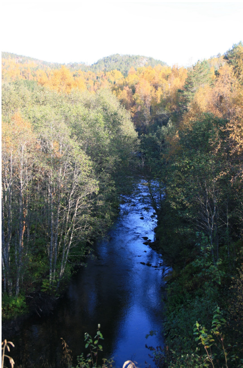
Figur 3.7 Elva sett fra veien. Høyspentlinjen sees i strekk over elva.
