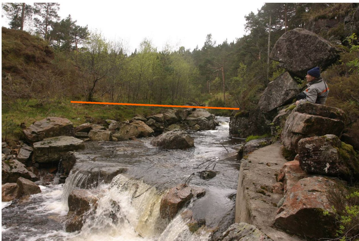
Bilde 3: Damsted sett motstrøms
