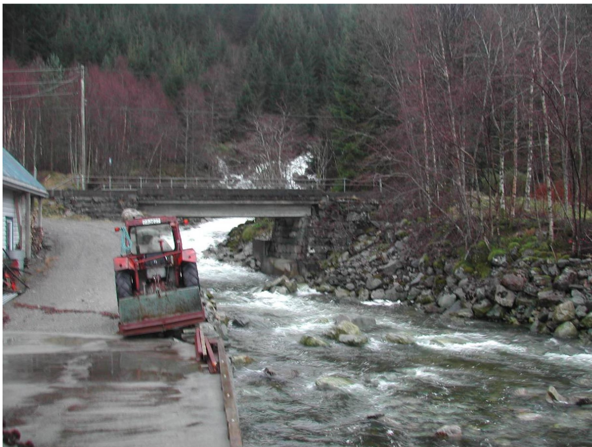
Bilde 7: Sandneselva like ovenfor fjorden/bru. Kraftstasjon inn til høyre ovenfor bru.
