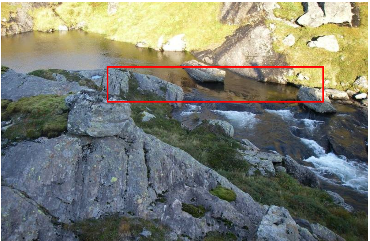
Inntaksdam/damsted sett fra vest. Damstedet er markert med rødt.
