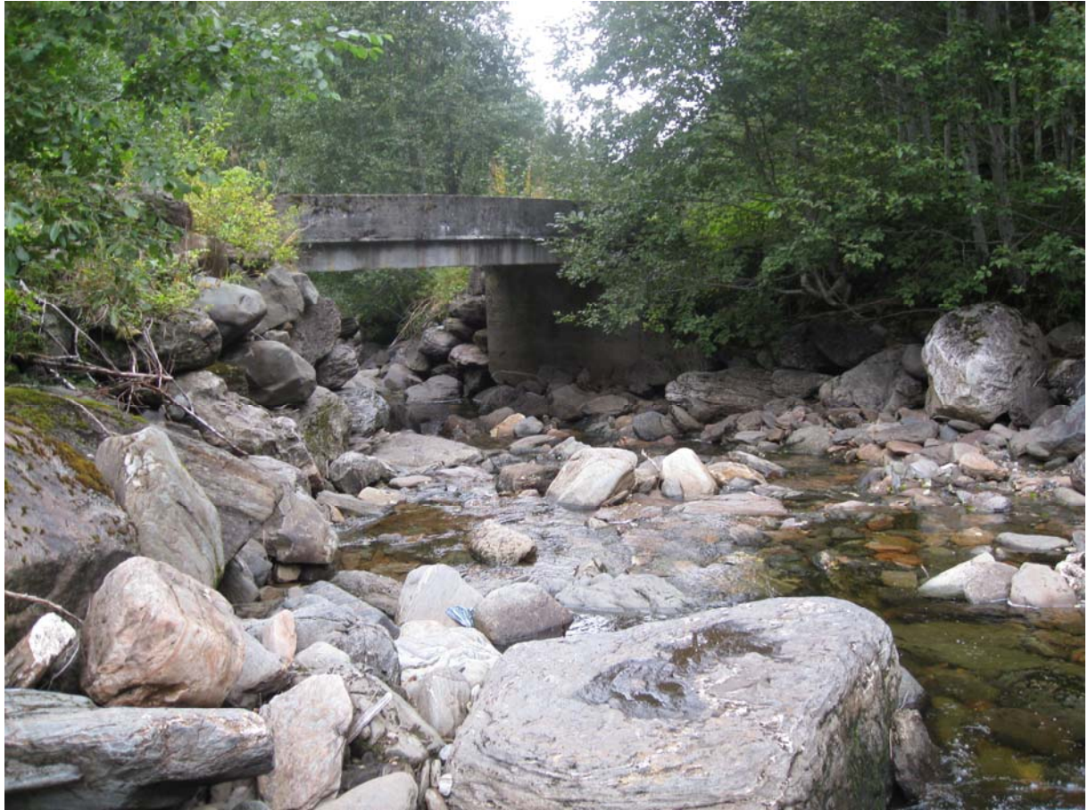
Figur 26 Betongbru over Mølska (ca 500 m oppstrøms kraftstasjonen). Benyttes som atkomst til vannverket.
