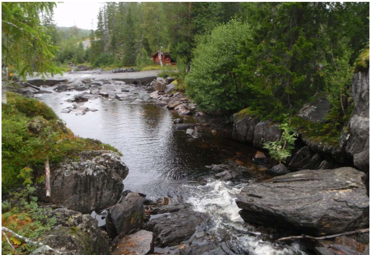
Figur 14 Fra inntak mot bru/kulvert. "Gapahuk" i tømmer ca 4 m til høyre for elva.
