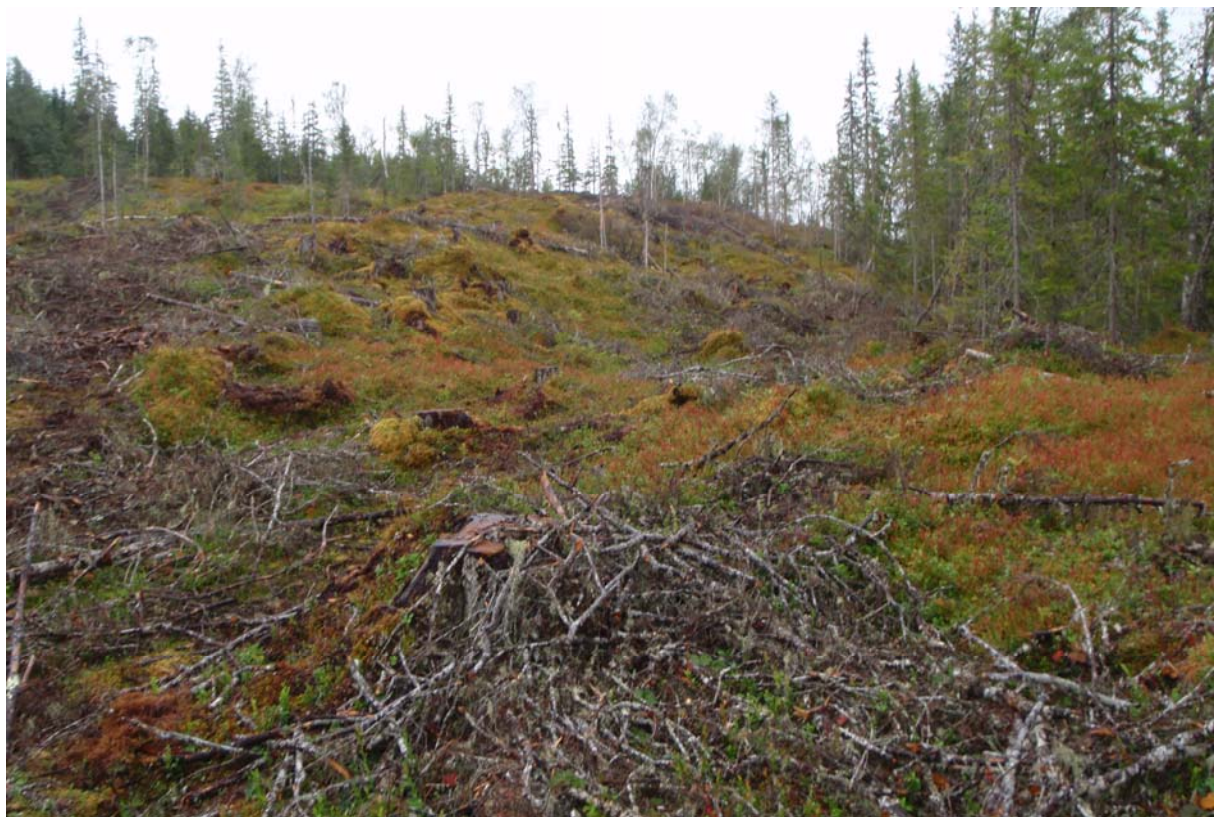
Figur 19 Ca 1,6 km fra inntak. Rørgate graves ned til høyre i bildet.
