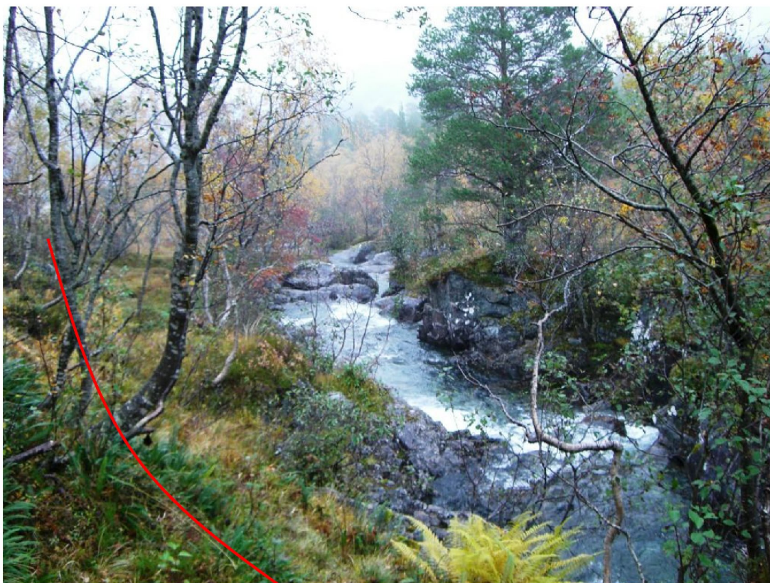
Bilde 11: Rørgate like nedstrøms inntak. Foto: Elvekraft.
