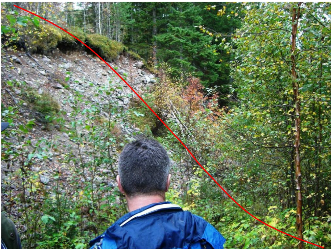
Bilde 13: Bratt grusrygg like ovenfor stasjonen. Foto: Elvekraft.
