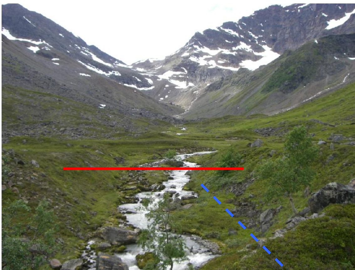
Bilde 1: Plassering av inntaksdam på kote 268 moh sett fra nedstrøms side. Foto: Elvekraft.
