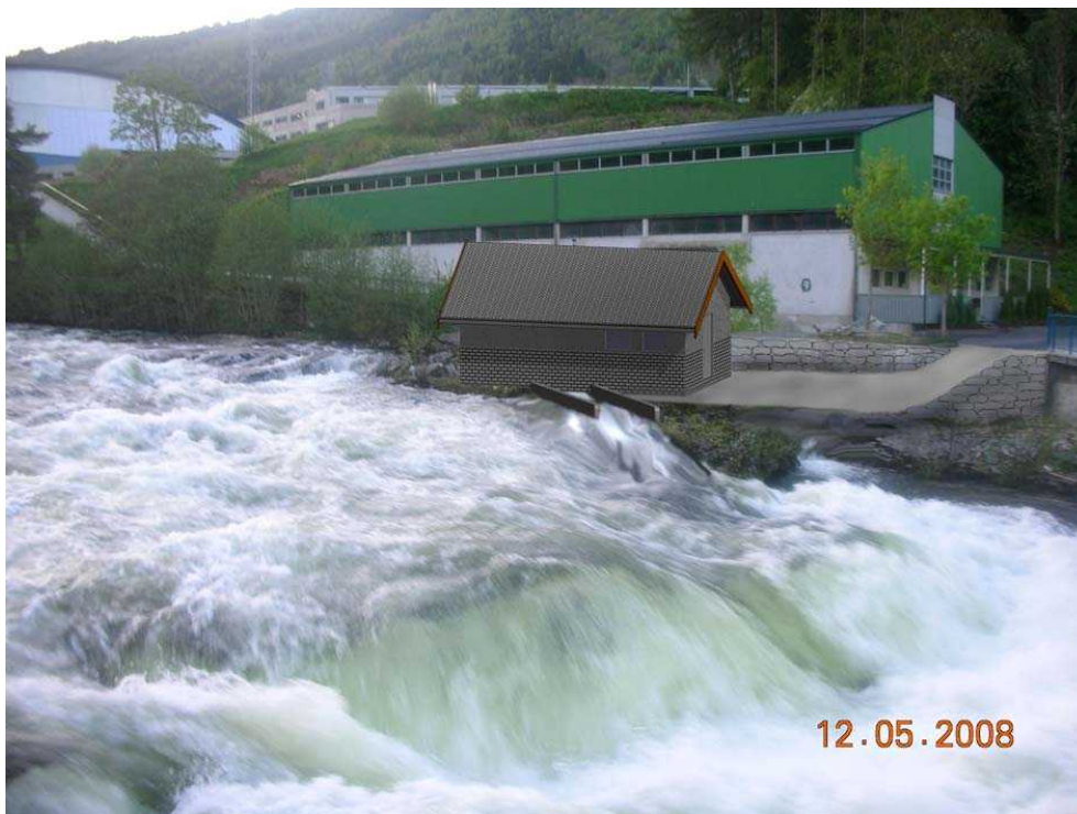
Bilde nr. 4. Område ved kraftstasjonen 12. mai -08 med forslag til plassering og utforming av ny kraftstasjon innlagt. Stor vassføring i elva, utrekna til 38,4 m 3 /s.
