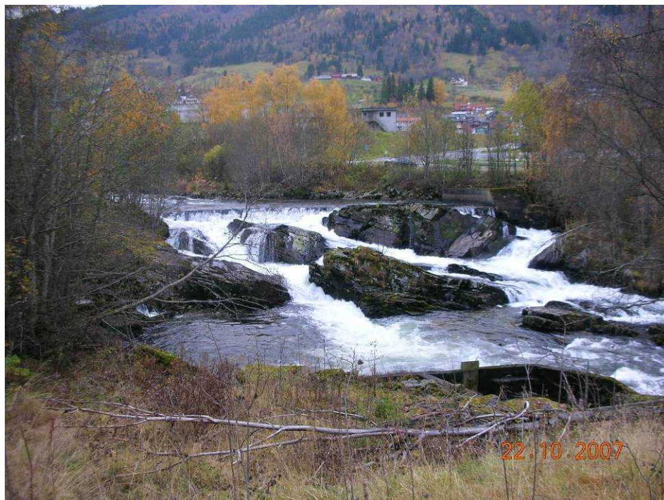
Bilde nr. 1. Område ved inntak sett nedanfrå, okt. -07. Til høyre syner betongkonstruksjon etter tidligere inntak.
