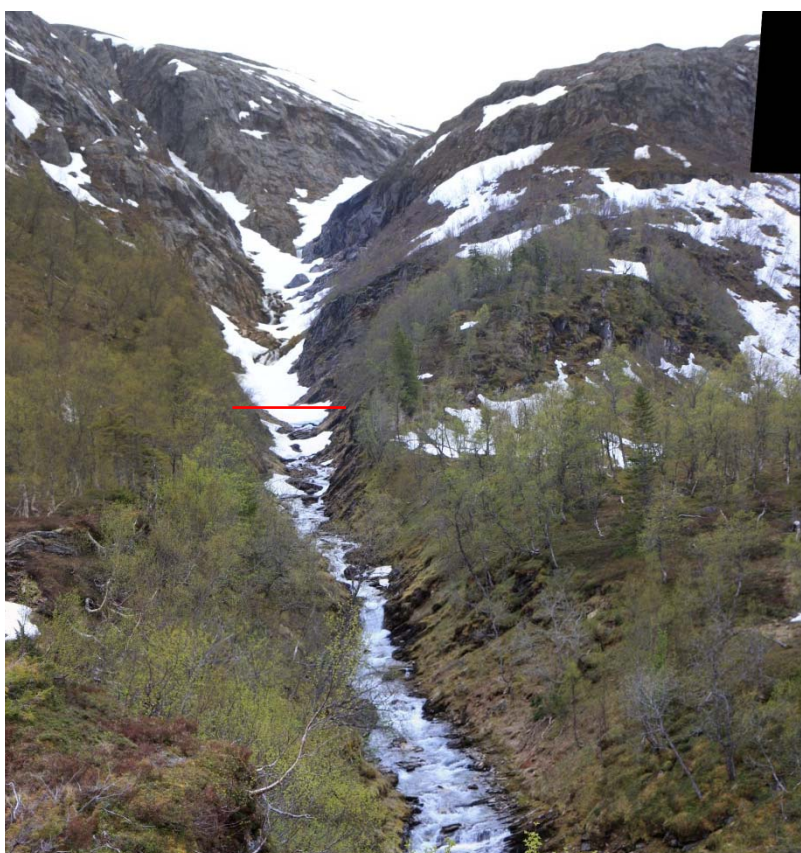
Inntaksområde Dragelva. Ca. plassering dam merket med rød strek.
