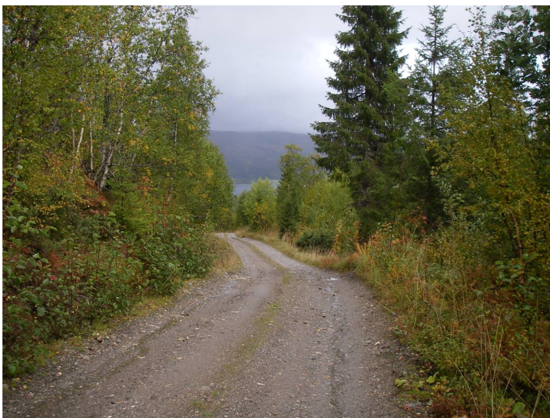
Rør graves ned langs vei
