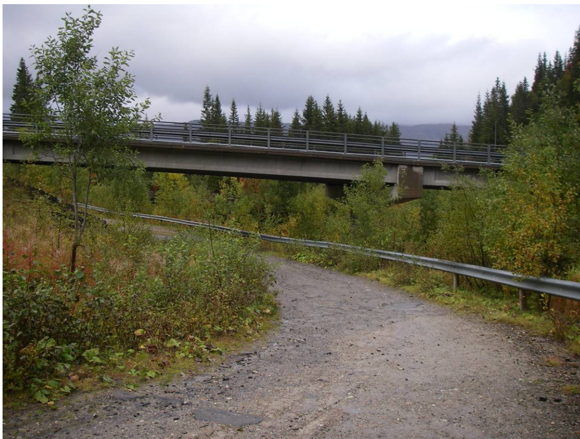
Rør graves ned langs vei under bru
