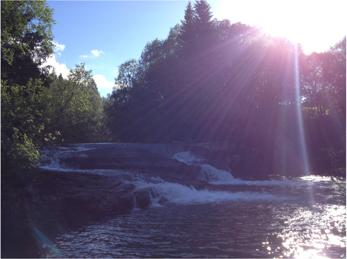
Stasjonsområdet og vannintak for klekkeri.
