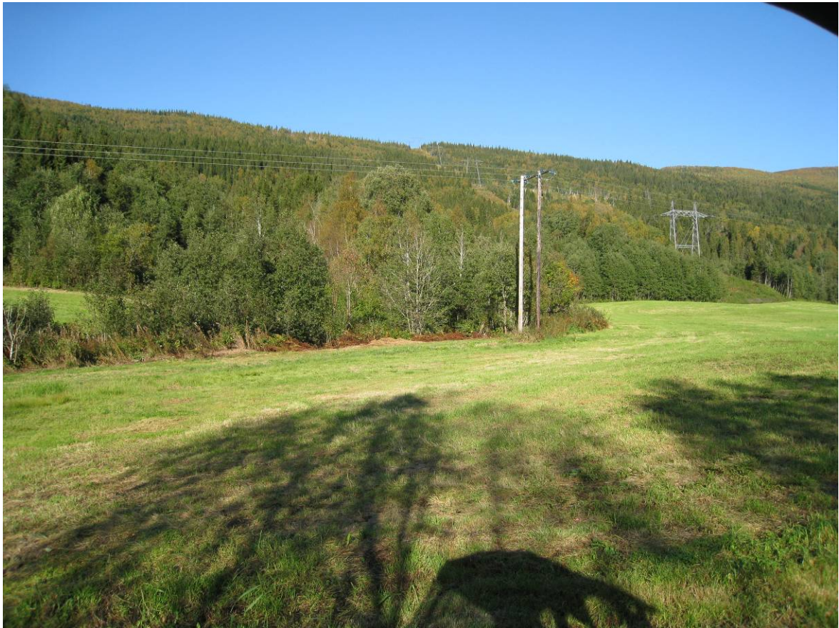
Bilde 5.1 Eksisterende 22kV kraftlinje, ca 100 m fra stasjonsområdet
