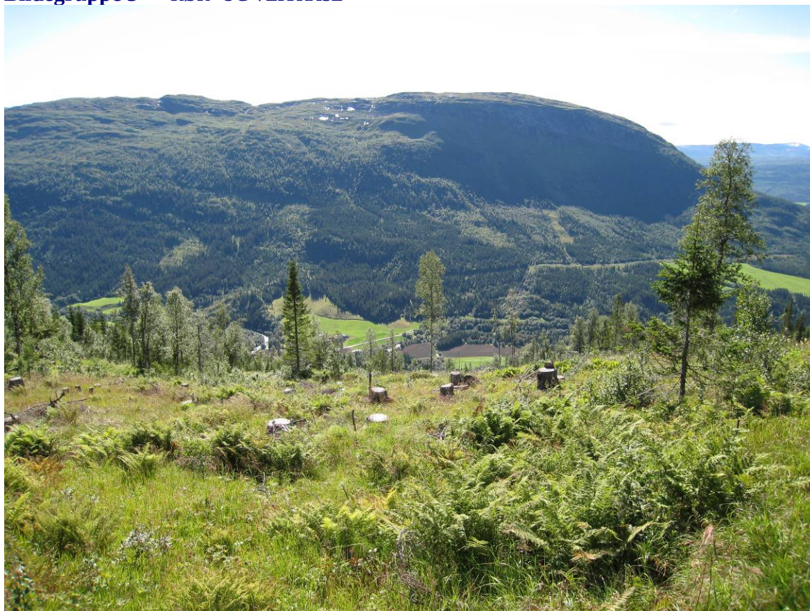
Bilde 3.1 Rørtrase nedenfor inntaket
