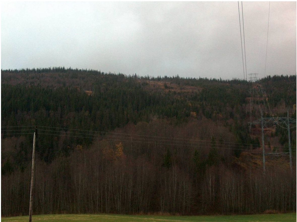
Bilde 3.3 Nedre del av rørtrase
