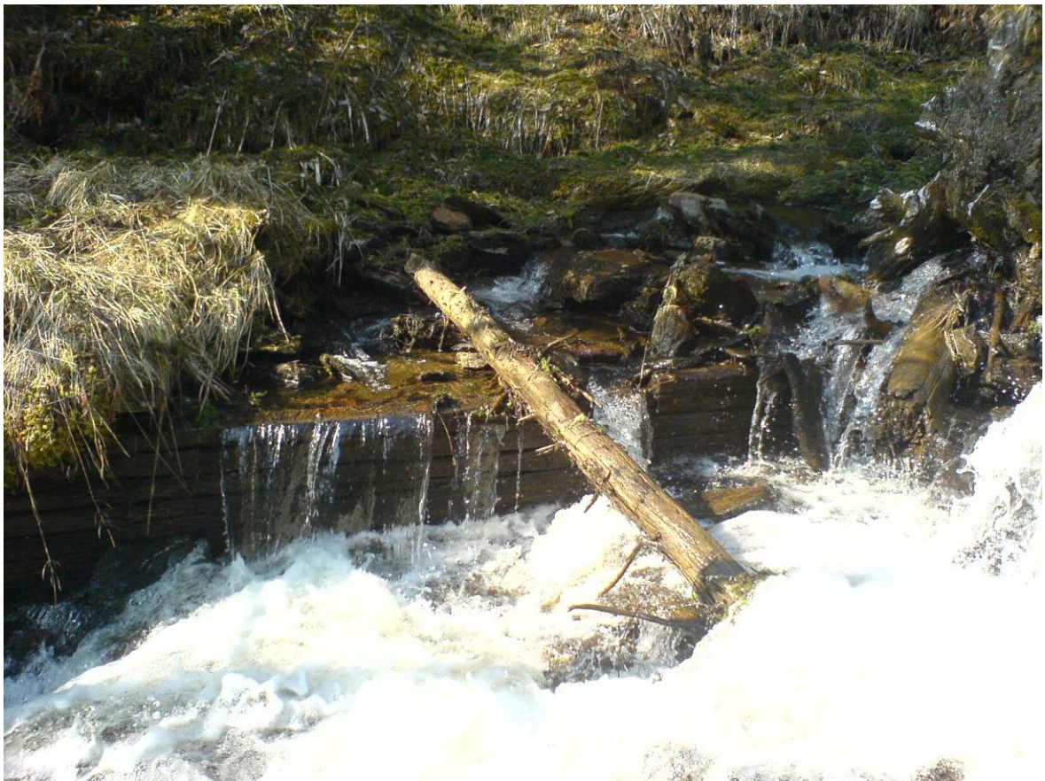
Bilde 6.3 Inntak til det gamle kraftverket
