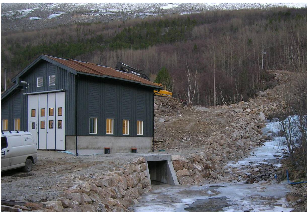
Bilde 06.b Kraftstasjonen på Lappvikelva kraftverk
