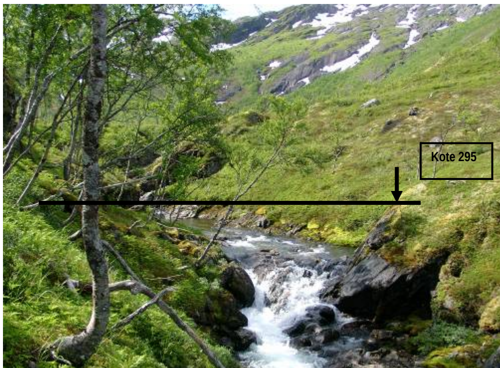
Bilde 03 Inntaksdammen i Sommersethelva, sett oppstrøms – topp dam ca. kote 295
