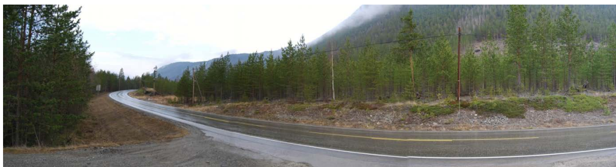
Figur 9. Bilde tatt fra rv.15 mot vest, med aktuelt deponiområde på oppsida av vegen
