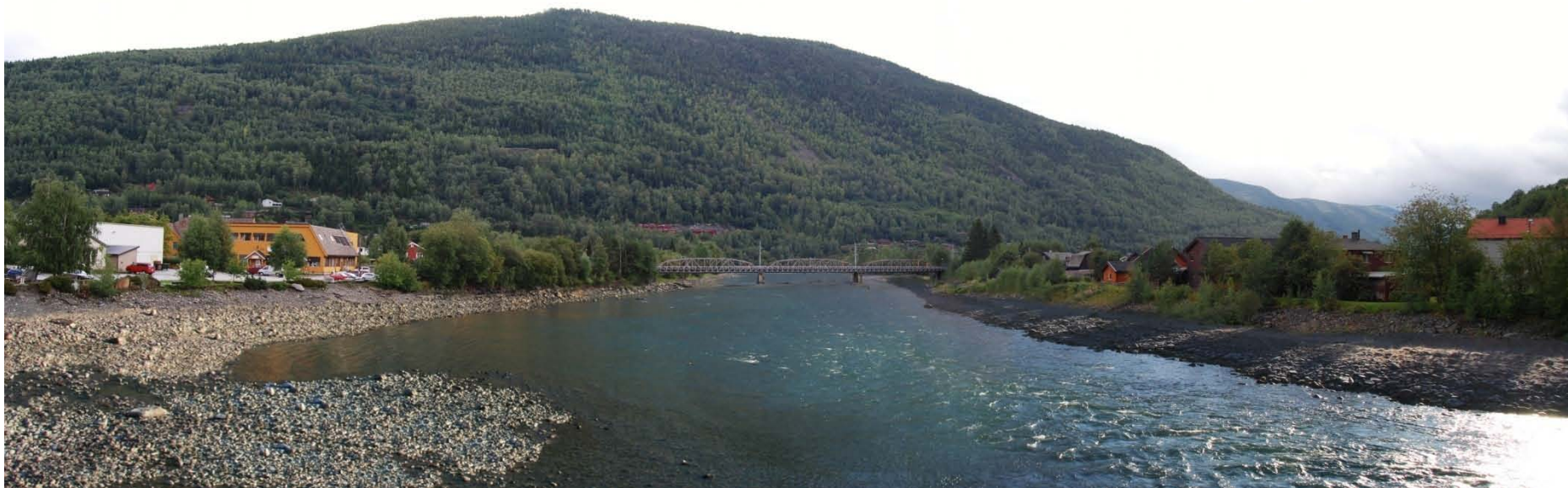
Ottaelva gjennom sentrum, sett mot jernbanebrua og utløp i Lågen. (Visualisering med redusert vannmengde, 20m 3 /s av LINK landskap)
