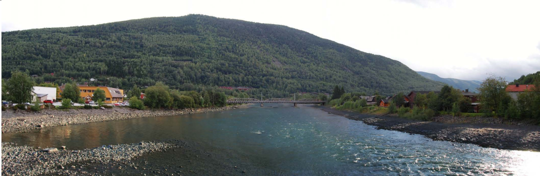
Ottaelva gjennom sentrum, sett mot jernbanebrua og utløp i Lågen. (Visualisering med redusert vannmengde, 30m 3 /s av LINK landskap)
