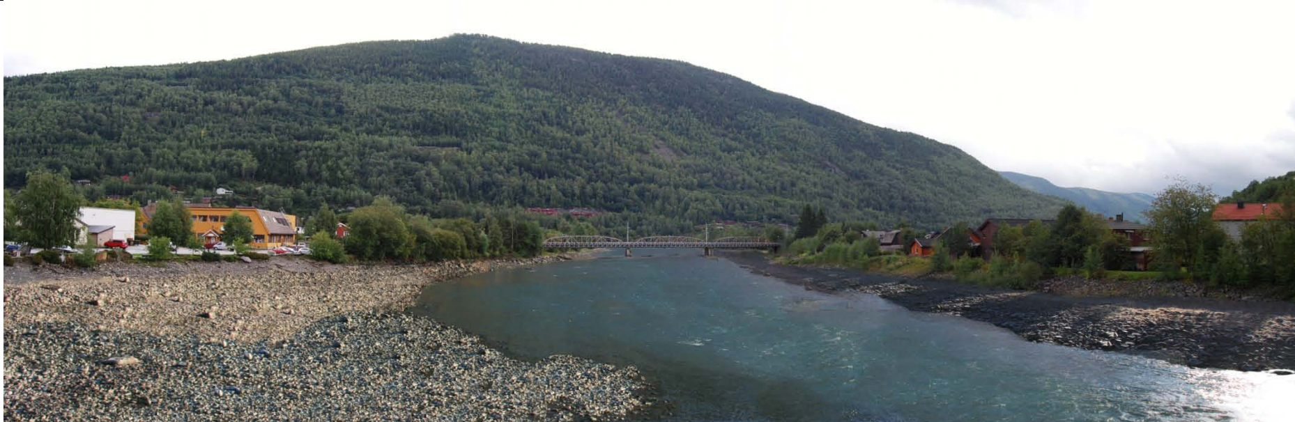
Ottaelva gjennom sentrum, sett mot jernbanebrua og utløp i Lågen. (Visualisering med redusert vannmengde, 10m 3 /s av LINK landskap)
