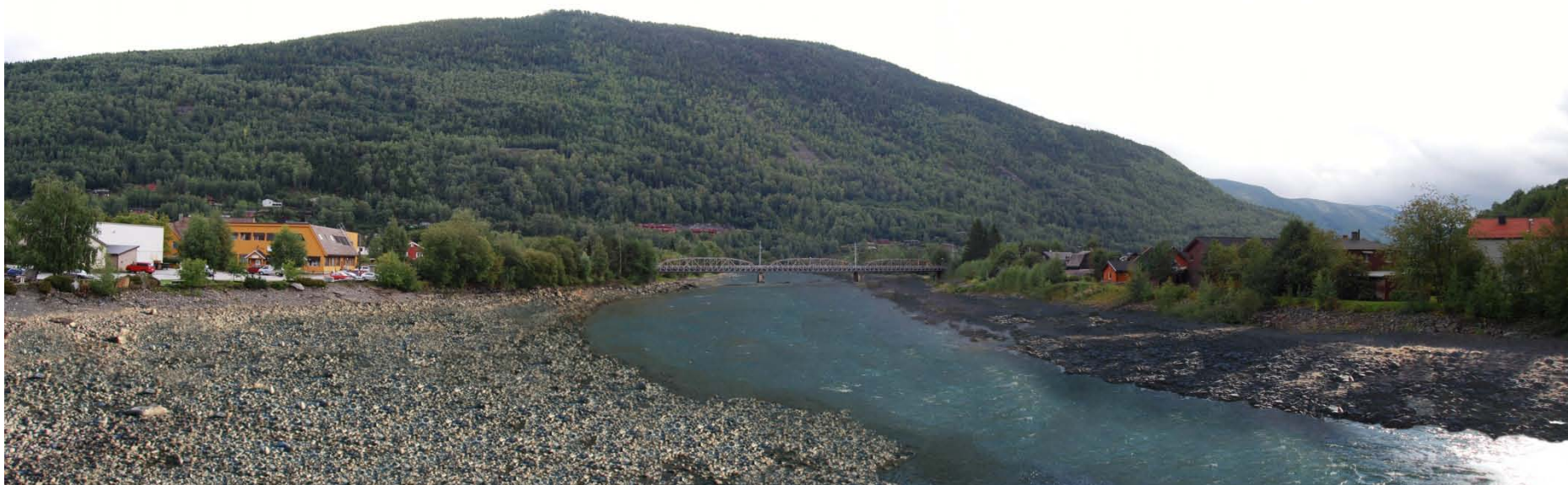
Ottaelva gjennom sentrum, sett mot jernbanebrua og utløp i Lågen. (Visualisering med redusert vannmengde, 5m 3 /s av LINK landskap)
