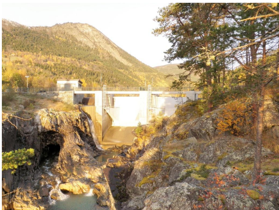
Eksisterende dam ved Eidefoss, Nedre Otta-vassdraget.
