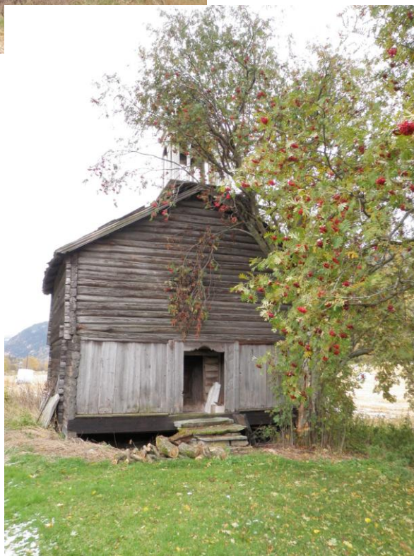
Stabbur på på Bredden søndre, lok. 46, med henholdsvis sørlig (over) og nordlig fasade (t.h.). Bygningen er datert til 1785. Bildene er tatt mot NØ og S. Foto: Øystein R. Andersen
