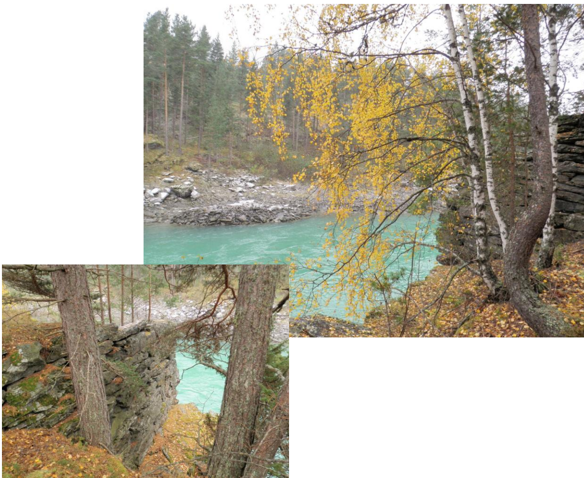
Brofundament, lok. 40, med detalj av oppmuring nede t.v. Bildene er tatt mot henholdsvis VNV og V. Foto: Øystein R. Andersen
