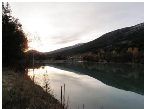
Bilde 4: Eksisterende inntaksdam ved Eidefoss. Inntakskonstruksjon for alternativ Pillarguri vil komme på motsatt bredd. Bildet er tatt mot SØ. Foto: Øystein R. Andersen
