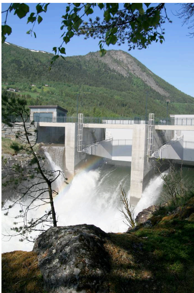
Figur 2.1. Eksisterende inntaksdam ved Eidefossen kraftverk.
