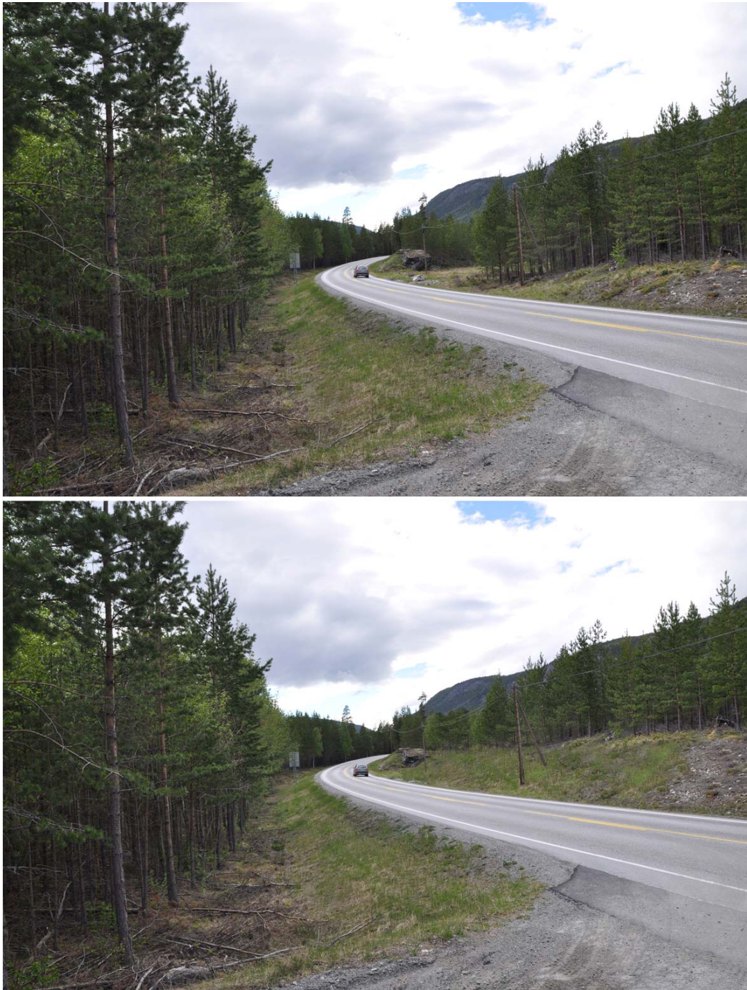
Figur 2.10 Deponiområdene sett fra riksvei 15 med standpunkt som vist på figur 2.9. Det nederste bildet er manipulert med deponiene ferdig vegetert. Kun deponi 1 er synlig i form av en brattere skråning opp fra veien.
