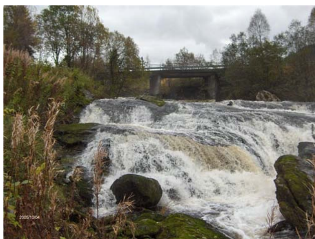
Brua og fossen sett nedstrøms ifrå.
