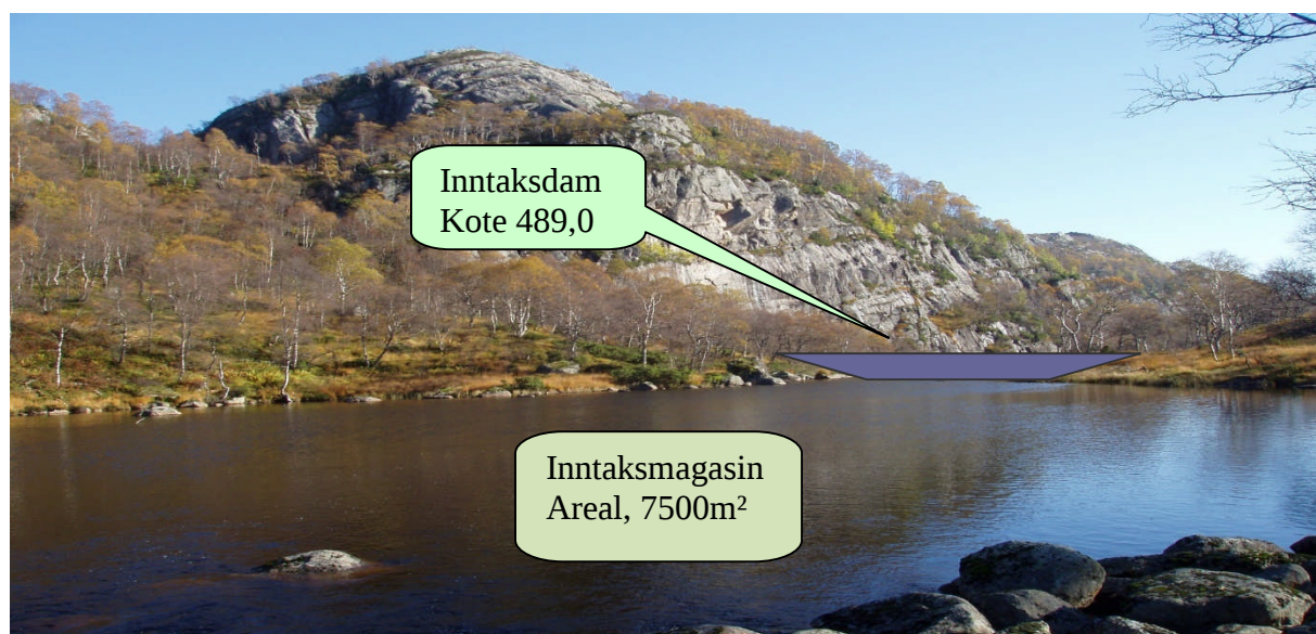
Inntaksmagasin sett fra oppstrøms
