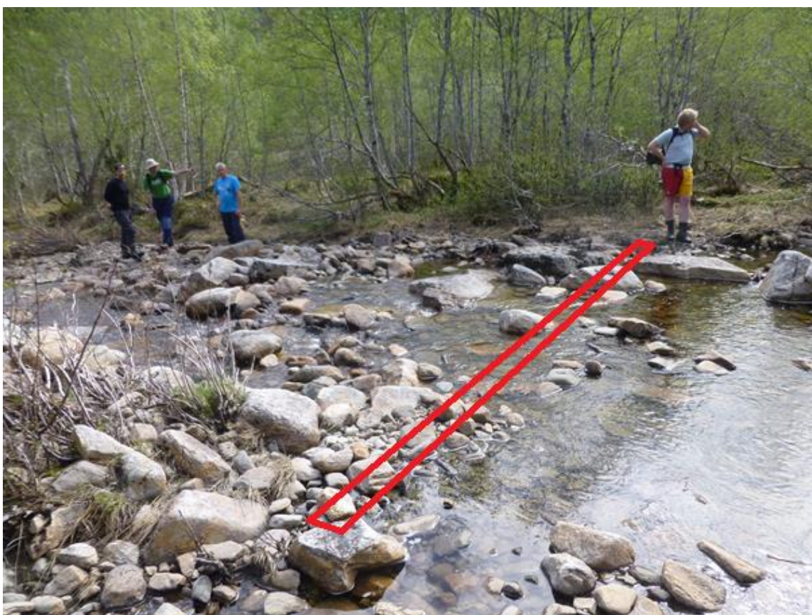
Figur 2. Lav terskel for å sperre av flomløp oppstrøms inntaket i Leneselva.
