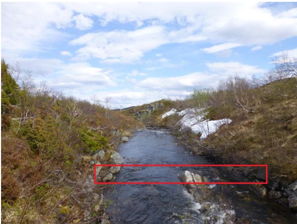
Figur 3. Inntaksdam Melslættelva, sett med strømmen.
