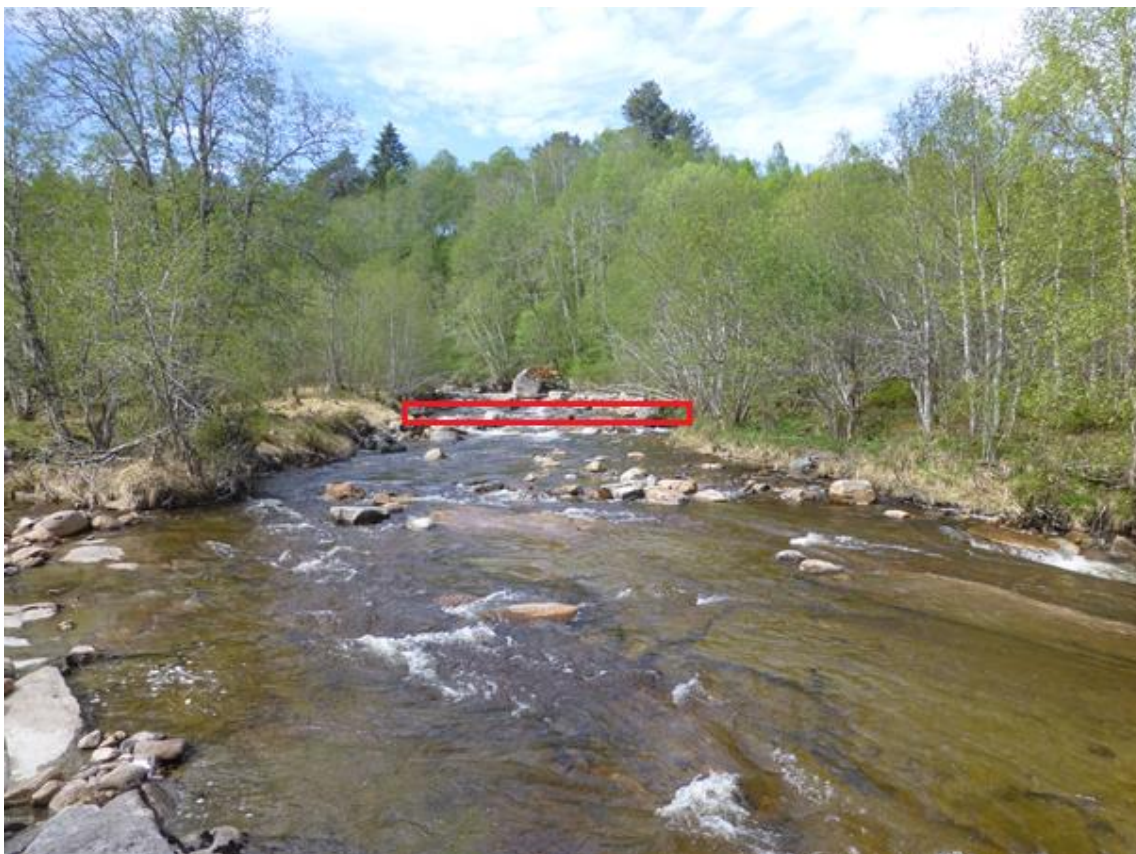
Figur 1. Inntaksdam i Leneselva sett nedstrøms.
