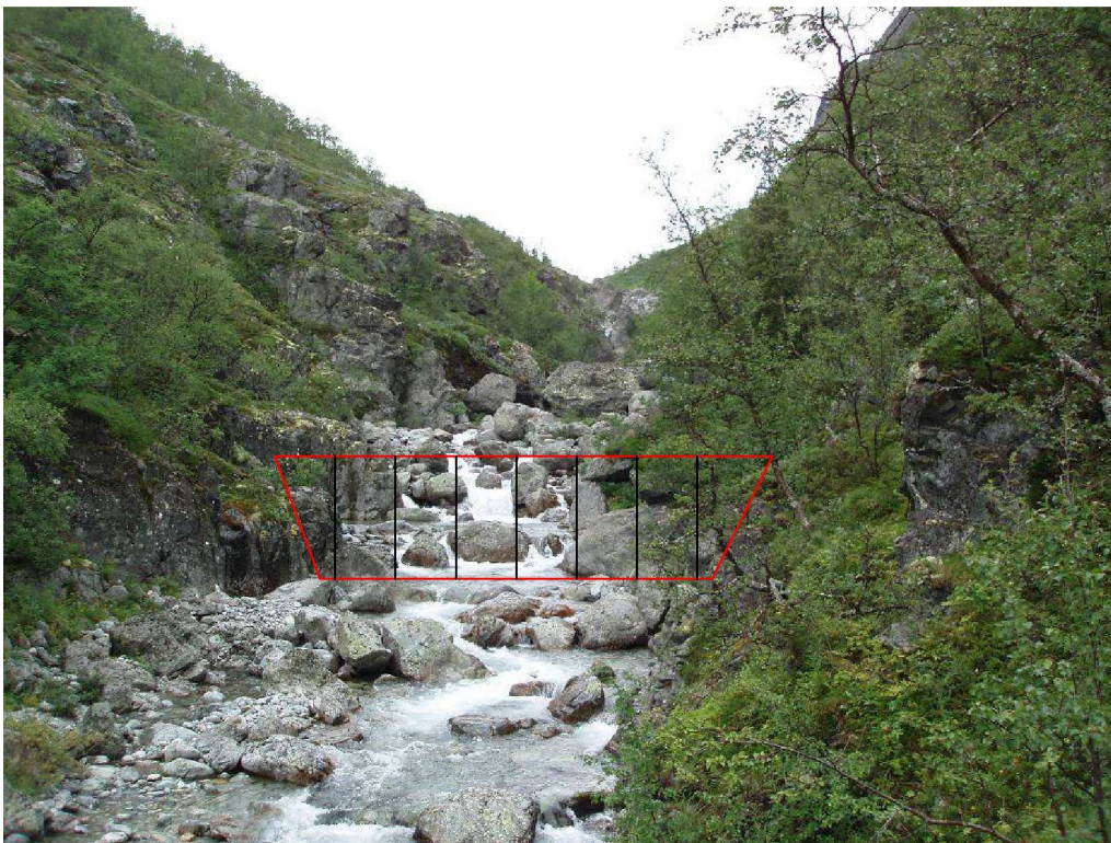
Bildet viser området for inntaket med sperredam sett fra nedsiden.
