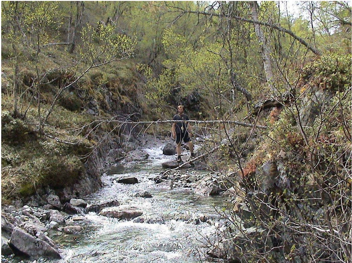
Bilde 1.2 Inntak i Åsaelvi– på ca kote 730 moh
