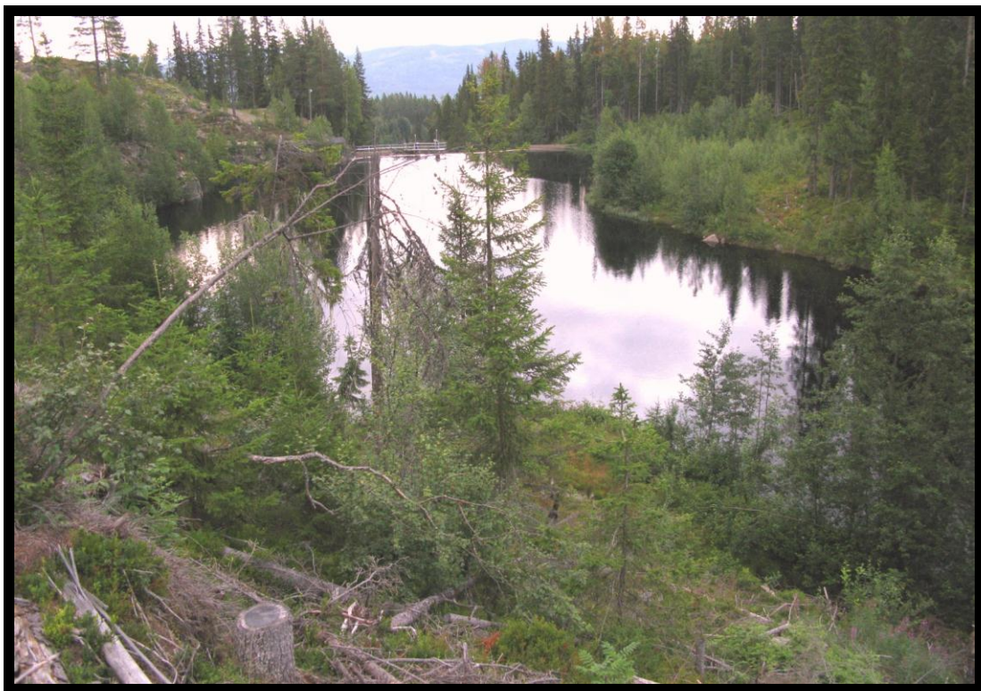
Lokalitet for ny kraftstasjon ved dam tilknyttet Storfallet kraftverk. Alle fotos: T.O.Nordvik
