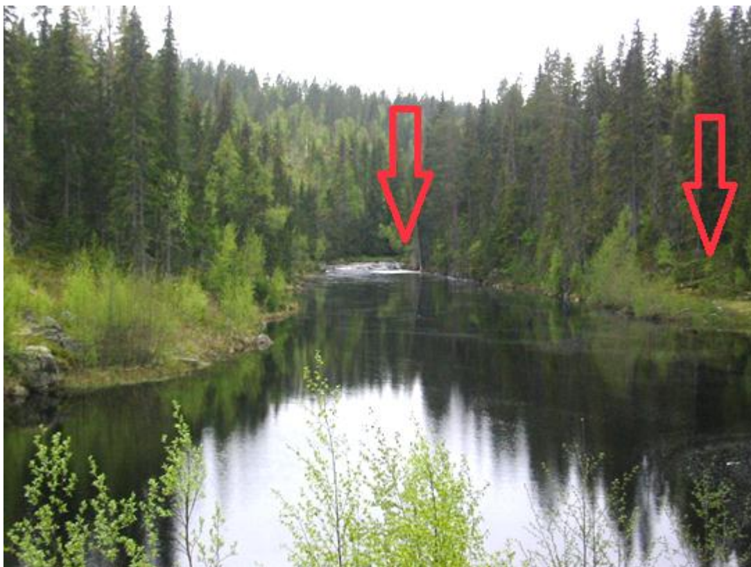
Bilde 6: Fra inntaksdammen for Storfallet. Kraftstasjonen planlegges plassert i området fra høyre side i svingen i elva, sett midt i bildet, til ved inntaksdammen til høyre i bildet. (De røde pilene angir området). Endelig plassering vil avgjøres under detaljplanleggingen.
