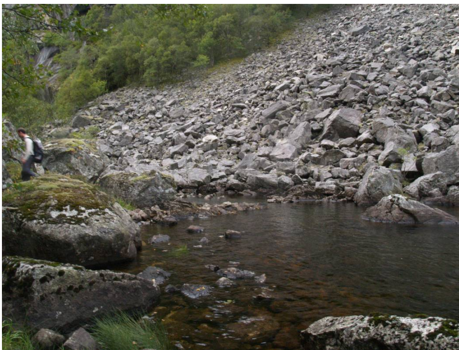
Bilde 10: Utløpet av Vassdalsvatn, inntak til venstre
