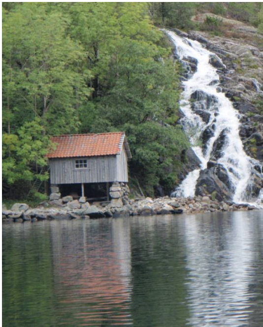
Bilde av vestre elveutløp og mølle, sett fra fjorden. Vannføring beregnet – 0,5 \text{ m}^3/\text{s} . Bildet er tatt 08.09.2008.
