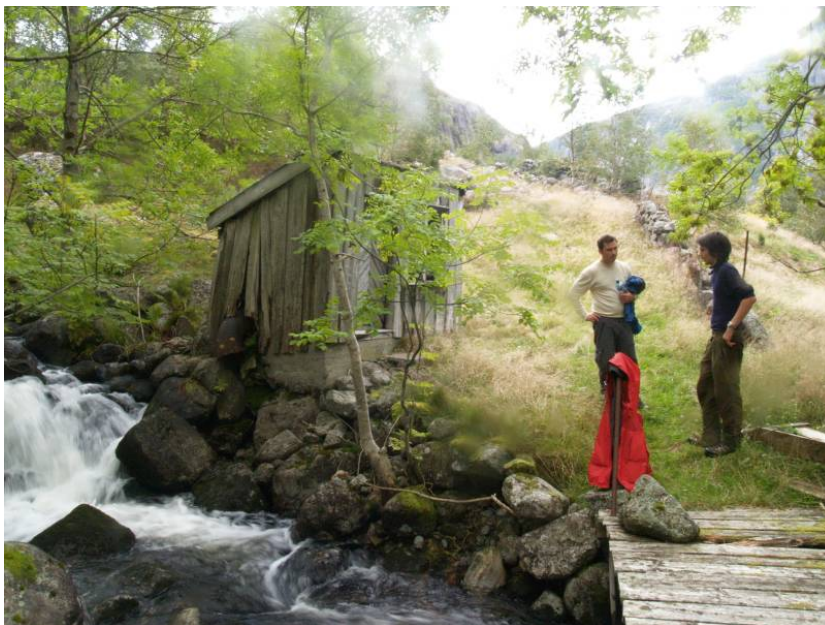
Bilde 5: 7 kW kraftstasjon i vestre løp
