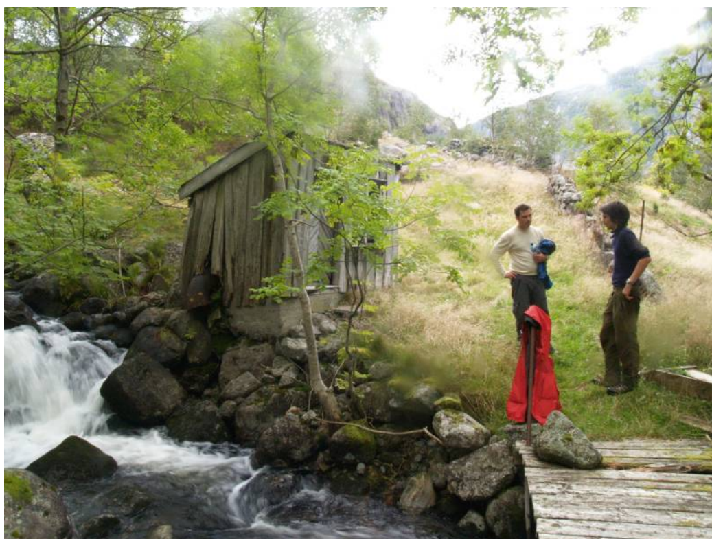
Bilde 5: 7 kW kraftstasjon i vestre løp
