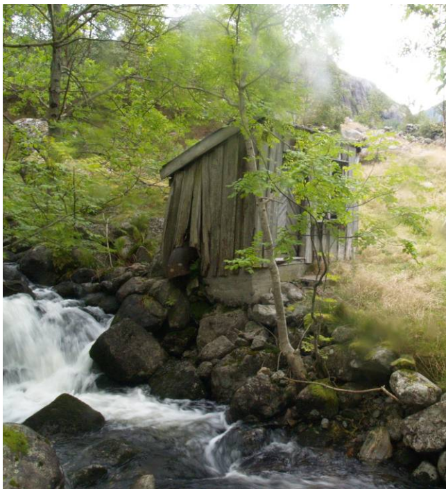
Figur 24. Rester av gammelt kraftverk ved Segadalasånas vestre elveløp.
