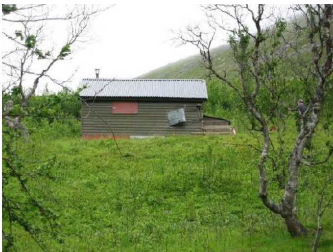
Bilde 15: Hytte på sørsiden av elva kote 374
