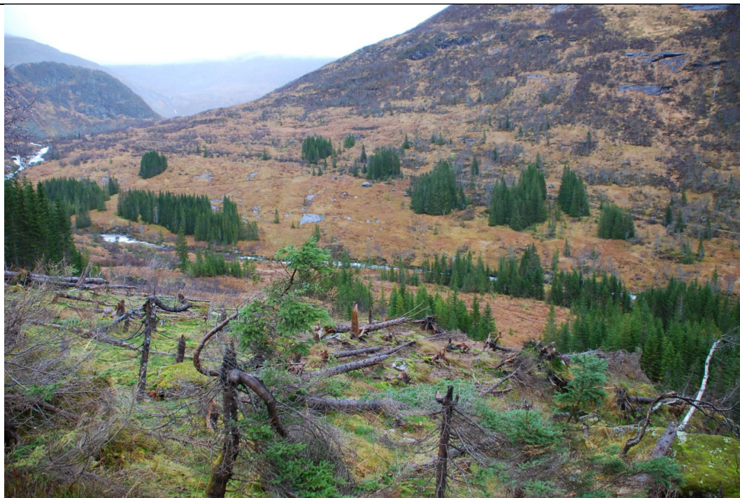
Øverste del av vannveien. Inntaksdam i øvre venstre del av bilde rett ovenfor der elva blir synlig
