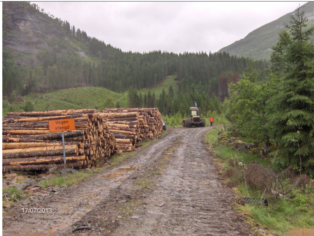
Nedre del av rørtrasee og eksisterende skogsbilvei
