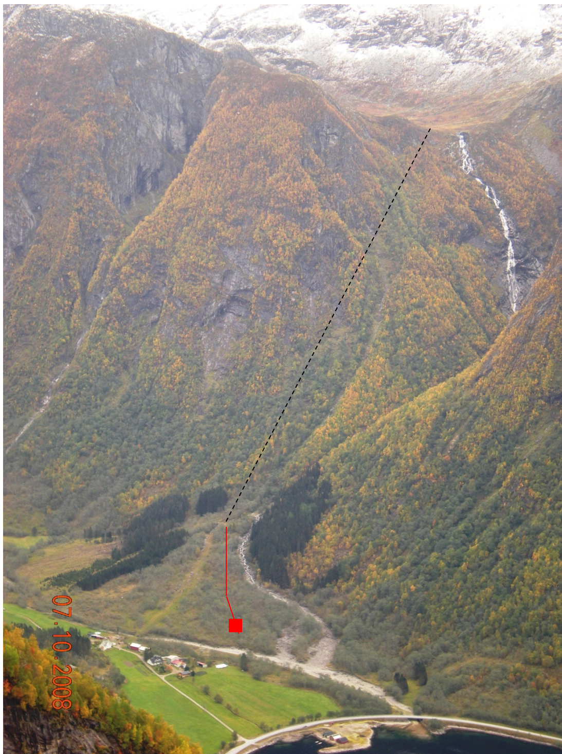
Bilde 11: Oversikt over anlegget tatt fra fjellet vest for Lånefjorden
