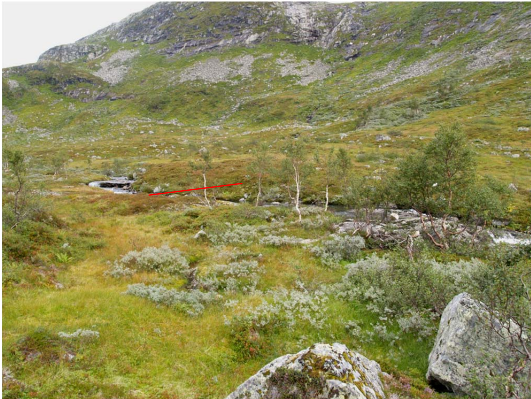
Bilde 7: Inntakssted sett fra nedstrøms side.
