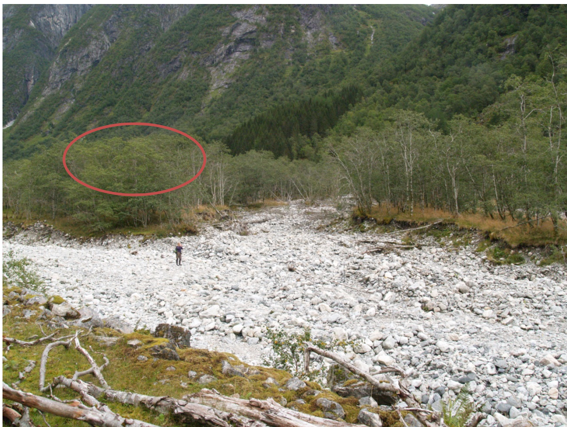
Bilde 10: Kraftstasjon i skogen nord for nordre flomløp, indikert med sirkel. Elva er helt tørr.
