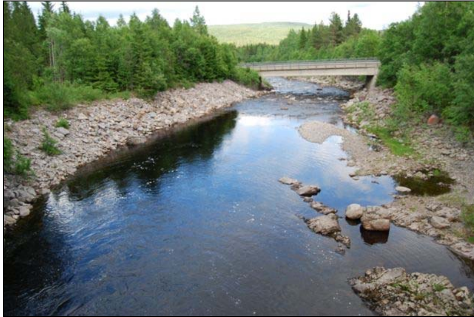
Figur 29 Hovda ved en vannføring på 2,5-3 m 3 /s.
