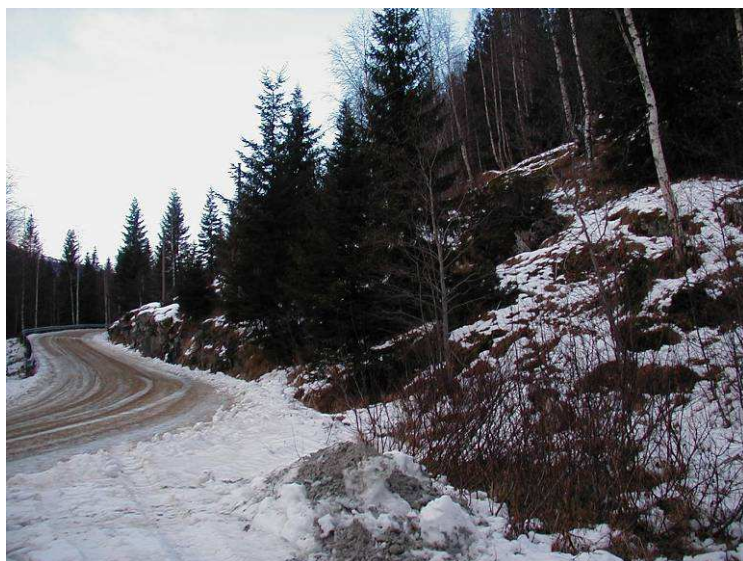
Bilde 6: Rør legges i fjellgrøft til høyre for kommunal vei.
