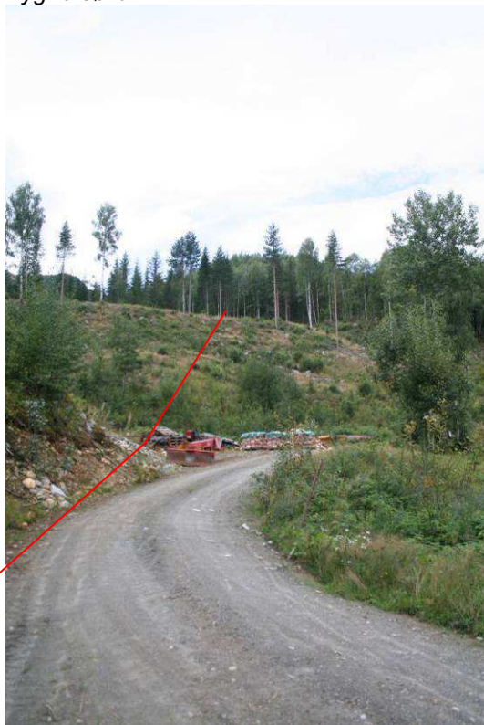
Bilde 11: Rørgrøft ned bratthenget ved Frygne søre
