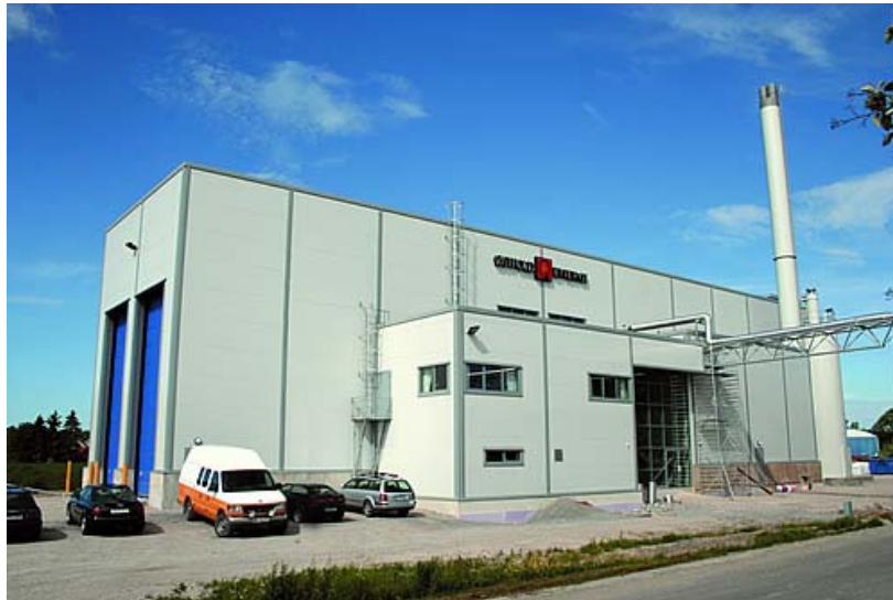
Figur 6 Rakkestad-anlegget (Østfold Energi AS)
