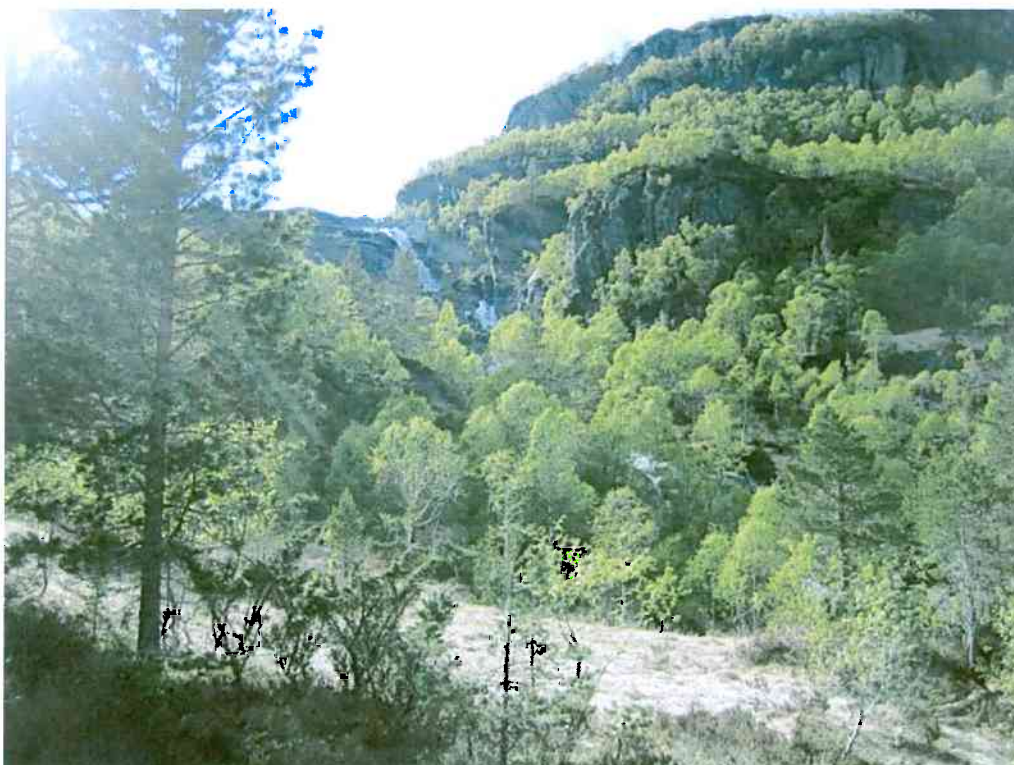
Kaldåna renn i stryk ned djuvet og gjennom lia. Inntak like ved toppen av vassføringa på biletet
