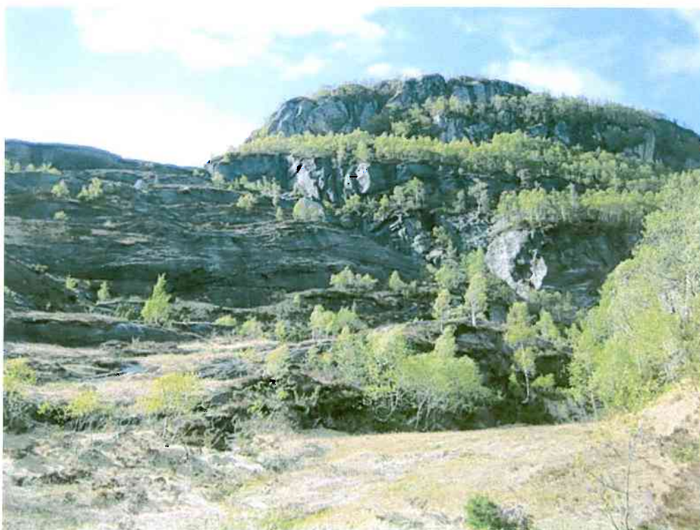
Fjellsida under tunneltraseen mot inntaksområdet
