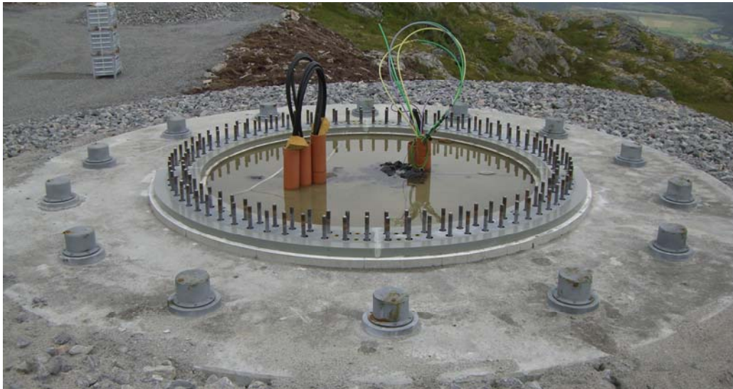
Figur 10. Fundament for 2,3 MW vindturbiner på Bessakerfjellet
