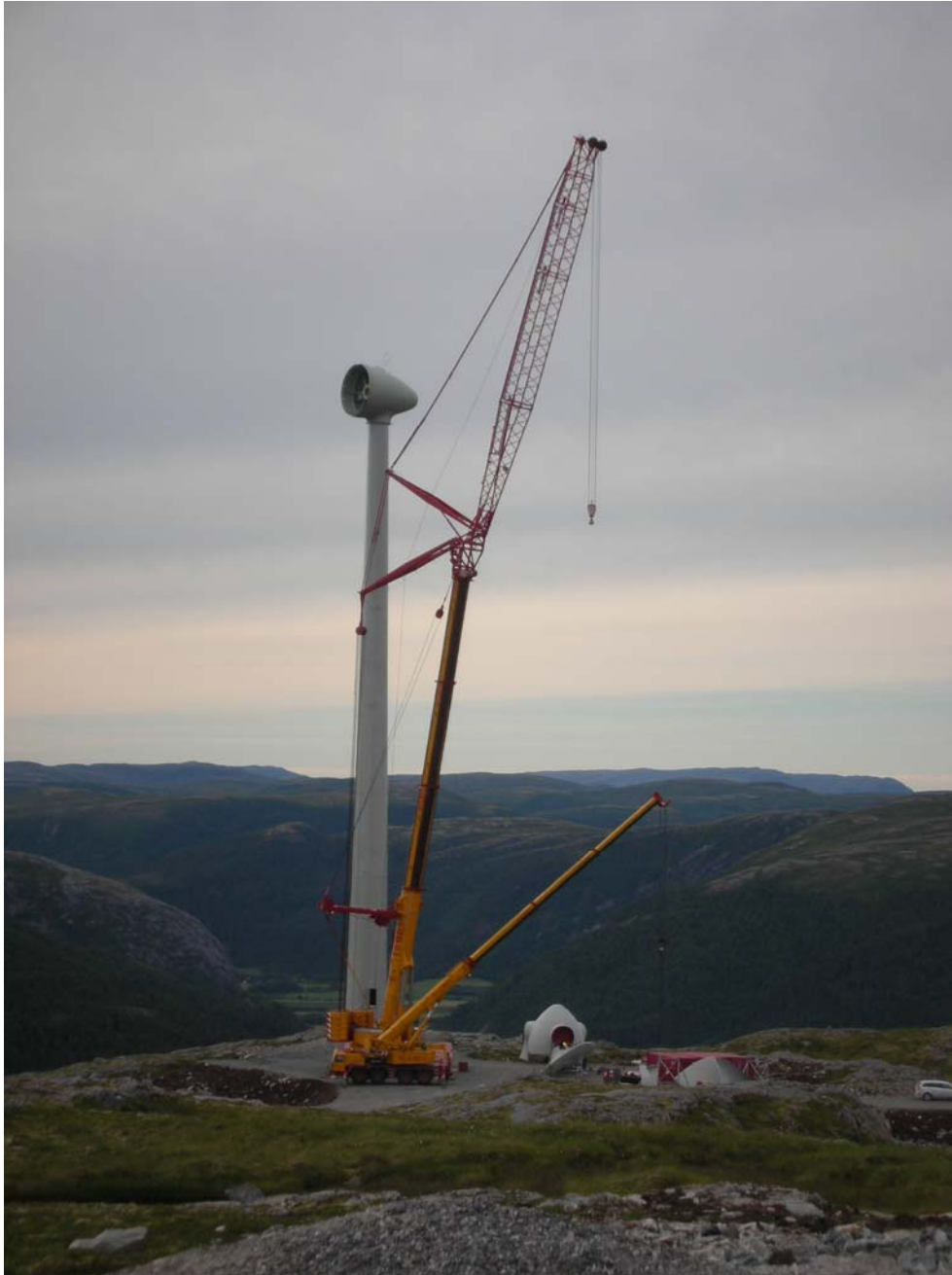
Figur 7. Montasje av vindturbin fra Bessakerfjellet
