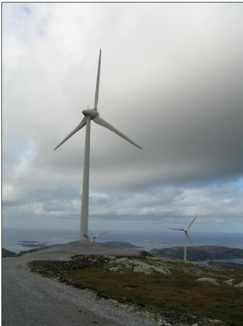
Figur 19: Kranoppstillingsplassene ved turbinene krever ca 1 daa flatt areal. På Bessakerfjellet I (bildet) er dette stedvis løst med fyllinger på fjellet. Dette er reversible inngrep og bør foretrekkes fremfor omfattende utsprenninger
