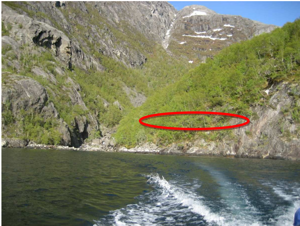
Figur 10 Kraftstasjon plassering (Foto: Elvekraft, 2008).
