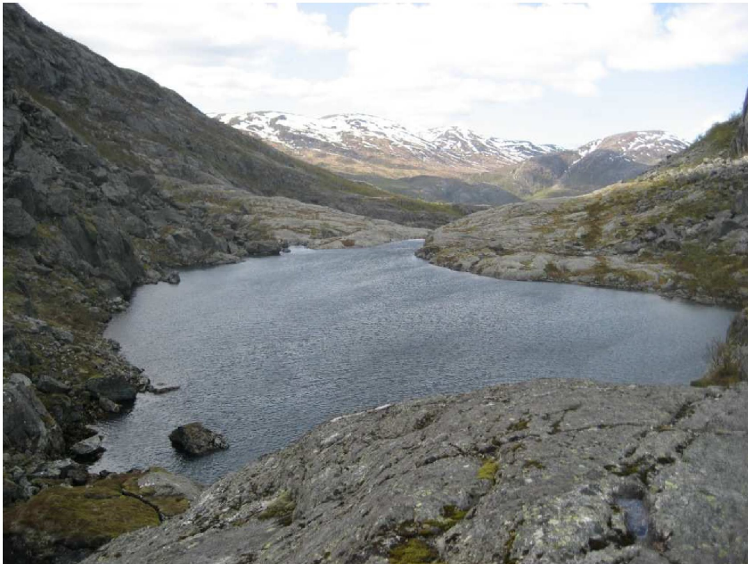
Figur 22 Dam sett oppstrøms ved terskel til Øvre Kalklavvatn (Foto: Elvekraft, 2008)
