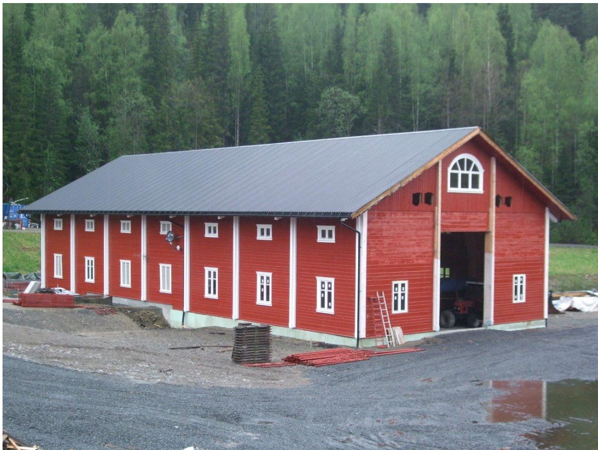
Figur 21: Veslefallet Kraftverk, prinsipp for kraftstasjon for Bjørrelva Kraftverk. Stasjonen er oppført på betong med limtrebuer og slipplåft, samt heltretak med plater. De 3 seksjonene til høyre i bildet er redskapshus som benytter overskuddsvarme fra kraftstasjonen til oppvarming.
