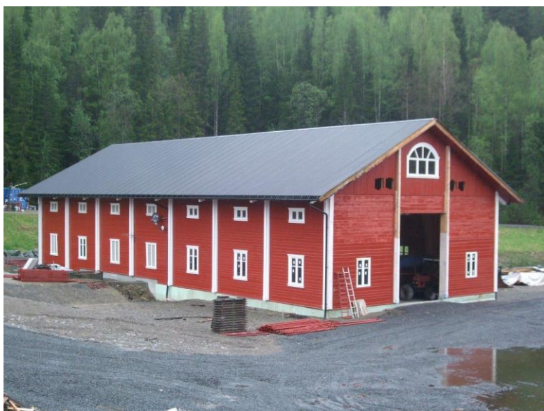
Figur 23: Veslefallet Kraftverk, prinsipp for kraftstasjon for Flåttådalselva Kraftverk. Stasjonen er oppført på betong med limtrebuer og slippluft, samt heltretak med plater. De 3 seksjonene til høyre i bildet er redskapshus som benytter overskuddsvarme fra kraftstasjonen til oppvarming.
