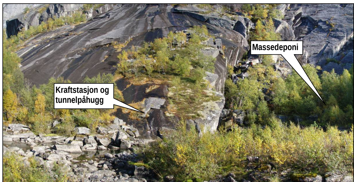
Figur 12 Bilde av kraftstasjonsområdet.
