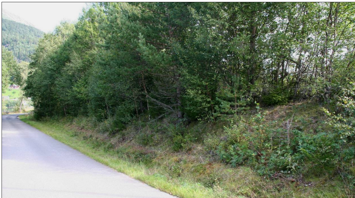
Figur 5. Felles kraftstasjonsbygning for Vossadalselvi og Merkesgrovi vert liggjande på kote 15, nær Evangervatnet. Foto: Ole Kristian Spikkeland.
