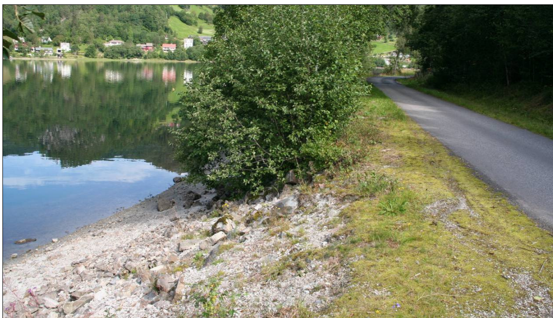
Figur 6. Vassvøre kraftstasjon har utlaup mot Evangervatnet. Foto: Ole Kristian Spikkeland.
