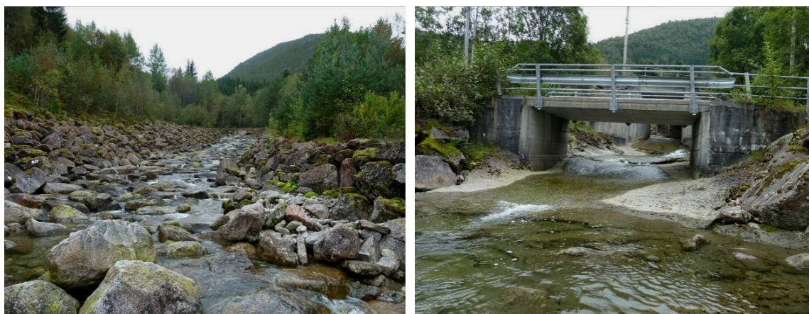
Figur 20. Øvre del av anadrom strekning i Vossadalselvi er plastra med blokk. I nedre del er store delar av elvestrengen fylt igjen med betong. Foto: Bjart Are Hellen.
