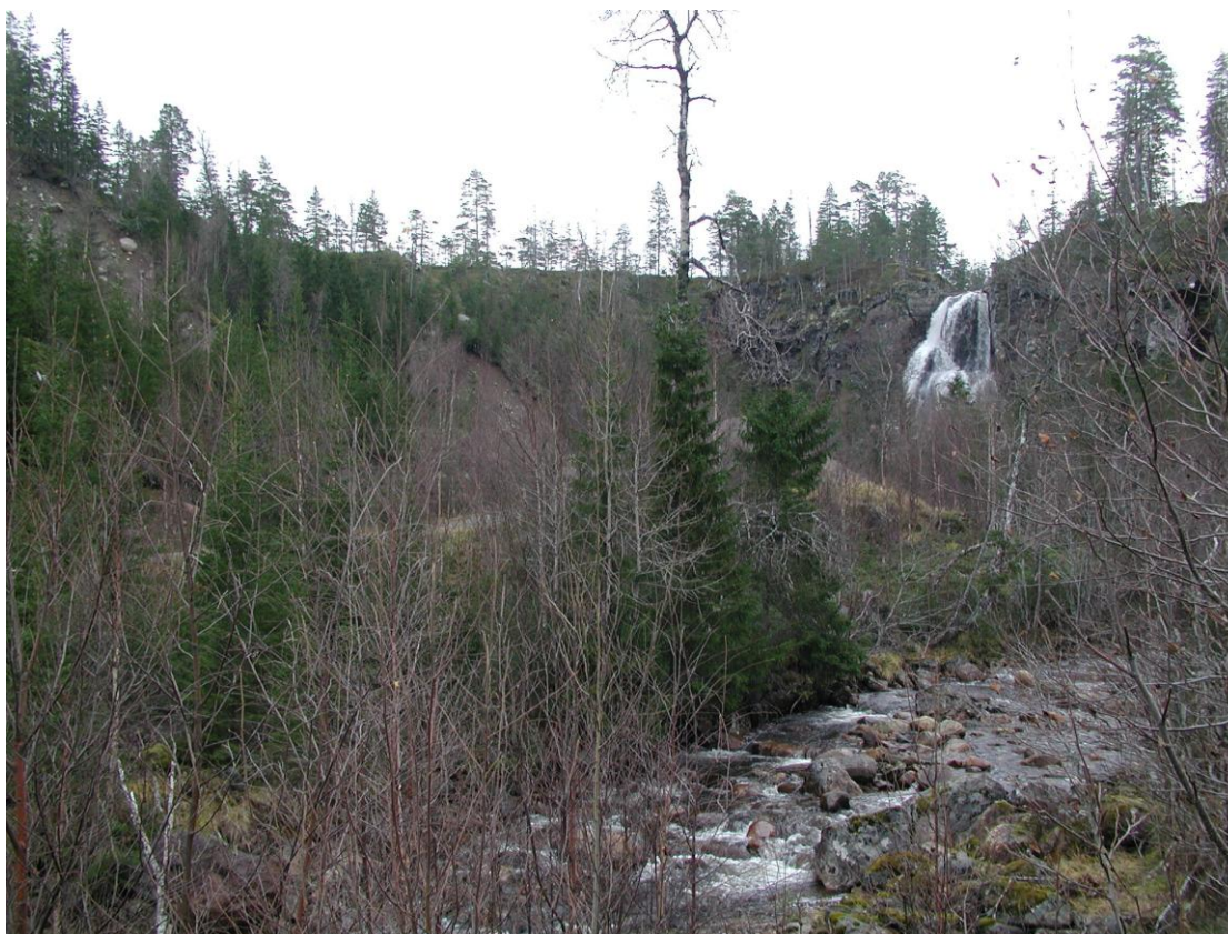
Bilde 1: Den øverste fossen sett nedenfra vegen (brua over elva). Inntaket ligger like innenfor fossenakken. Rørtraseen legges bak grustaket til venstre på bildet (01.11.2005).
