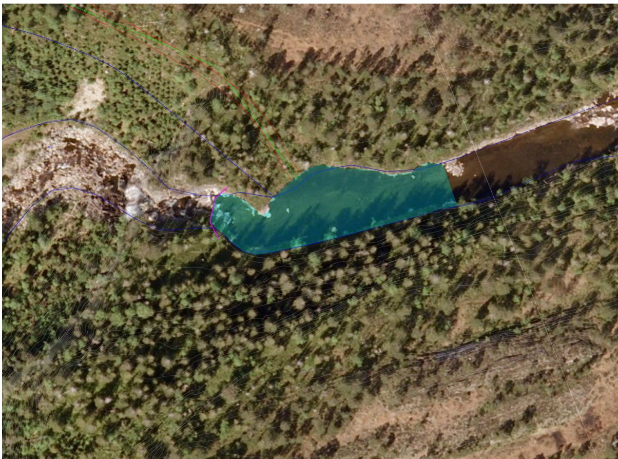
Figur 2 Utstrekning av inntaksbasseng. Dam er markert med rosa strek, grense verneområde er markert med hvit strek på tvers av elva til høyre i bildet.
