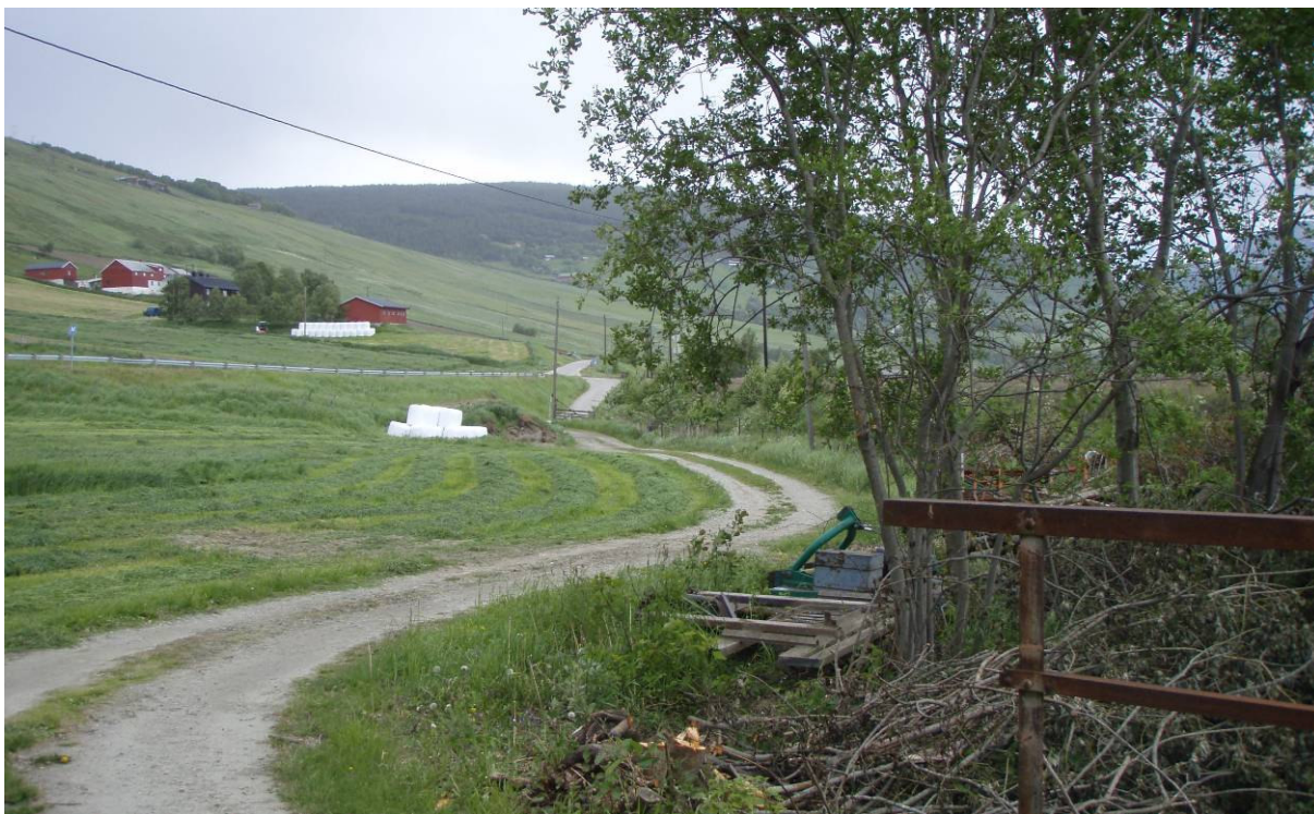
Kraftstasjonsområdet til Einbugga kraftverk
