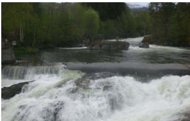
Vassføring 5-6 m 3 /sek. 11.05.2007. Sett frå brua mot dammen.
