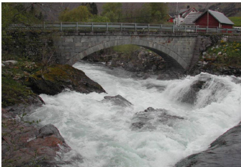
Storebrua sett frå planlagt stad for inntak
