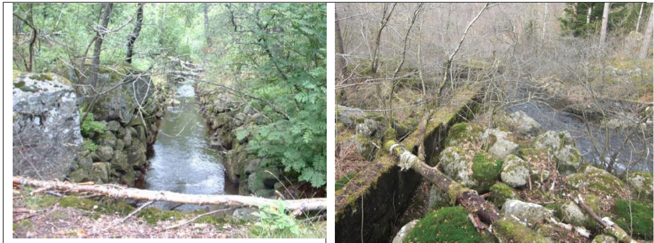
FIGUR 2: BILDE VISER KANALEN FRA OSESTADVANNET, SAMT DET GAMLE INNTAKSARRANGEMENTET TIL TIDLIGERE KRAFTVERK.
