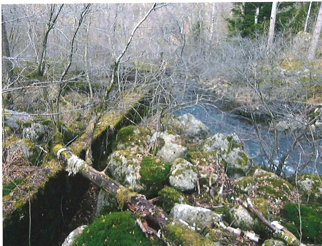
FIGUR 22: BILDET VISER INNTAKSOMRÅDE FRA TIDLIGERE KRAFTANLEGG I OSESTADBEKKEN.
