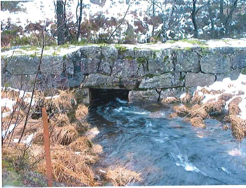
Figur 36: Bildet til venstre viser den eksisterende flomdempingen i Storavatnet.
