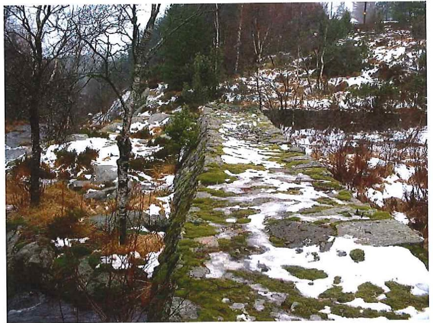
Figur 37: Flomdempingen sett fra siden. Den fremstår som et fortsatt fullgodt anlegg og kan benyttes videre i dag uten ytterligere endringer.
