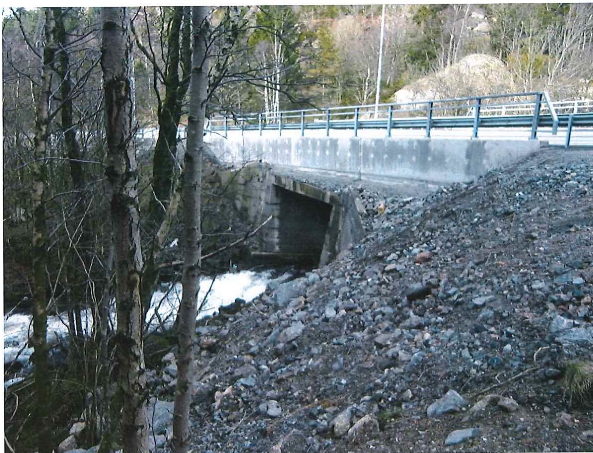
FIGUR 26: BILDET VISER BROEN OVER E39 VED INNTAKSOMRÅDET.
