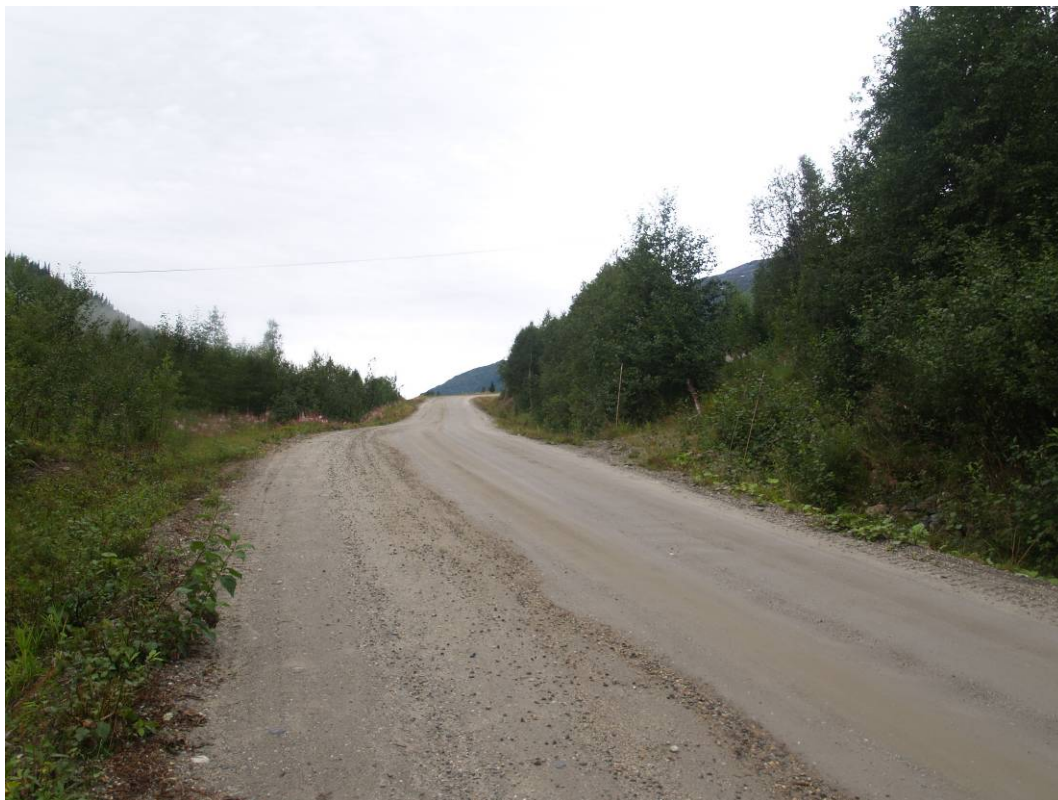
Bilde 7: Rørtrase i kant av dyrket mark over Svartisdalen gård
