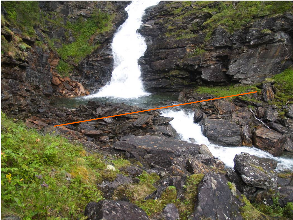
Bilde 3: Dam og inntak inn under øvre foss.
