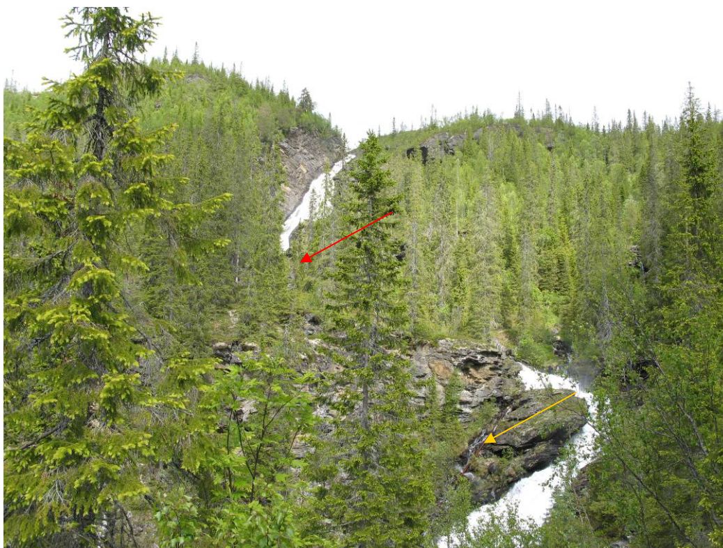
Bilde 2: Tverråga, fra k. 260 ned mot ca. k. 100. Rørgate for nedlagt kraftverk skimtes (gul pil). Lokalisering av inntakssted indikert med rød pil
