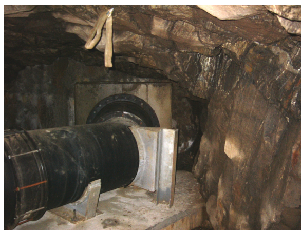
Bilde 4 innstøpt turbinledning i tunnelvegg.
