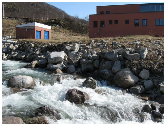
Bilde 13 Hovedelva (Simavikelva) nede ved vannbehandlingsanlegget
