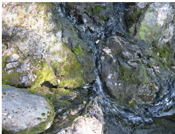
Bilde 11 Tilsig i bekk fra lekkasje. Ingen overløp fra demning, 2 august 2009
