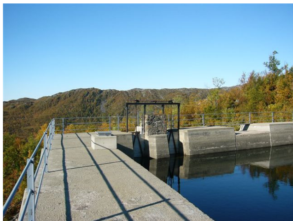
Bilde 1 Dam med overløp og flomluker
