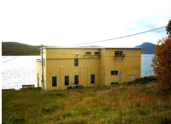
Bilde 7 Nedlagt kraftstasjon, sett mot sørvest
