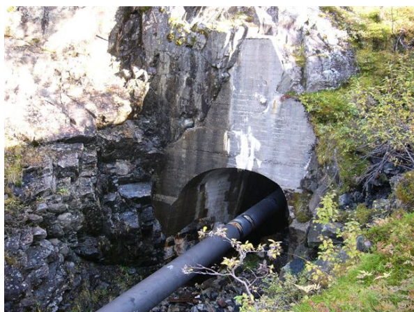
Bilde 3 Rørledning utifra tunnel
