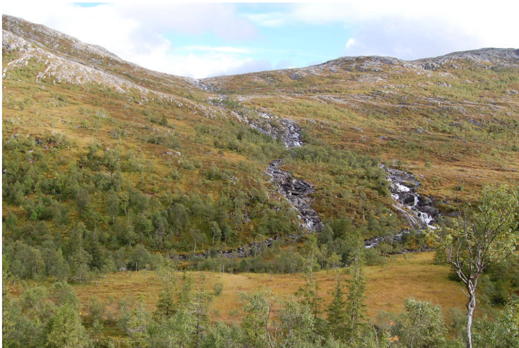
Bilde 2: Bilde av rørtrase ned mot planlagt kraftstasjon.
