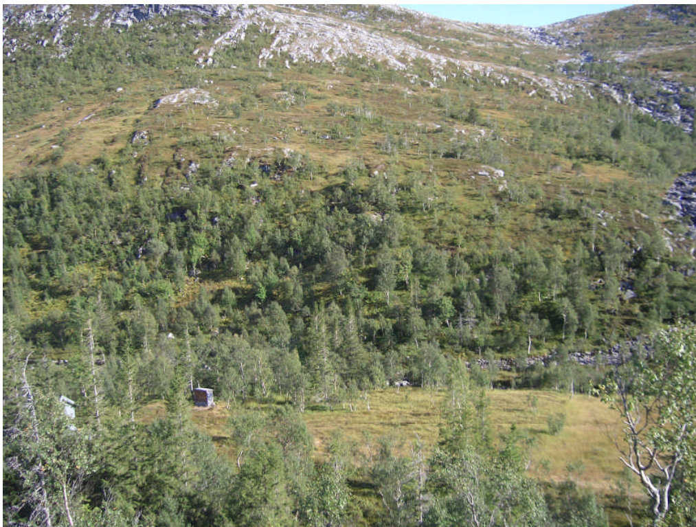
Bilde 12: Bilde av kraftstasjonsområde, og nedre del av rørtrase.
